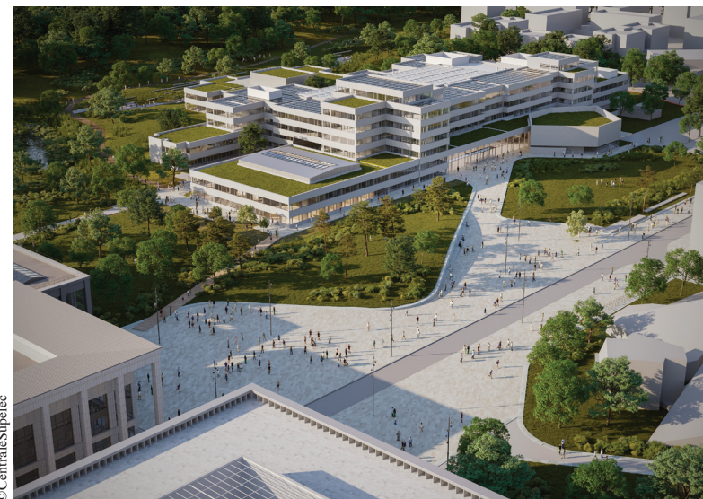
Le nouveau bâtiment Breguet de CentraleSupélec.
